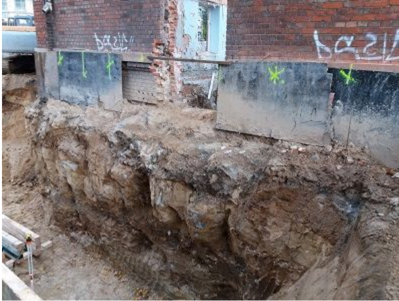
Podbicie istniejących łąw fundamentowych oraz ścian istniejącego budynku. Fot. od Soletanche Polska sp. z o.o. w Warszawie
