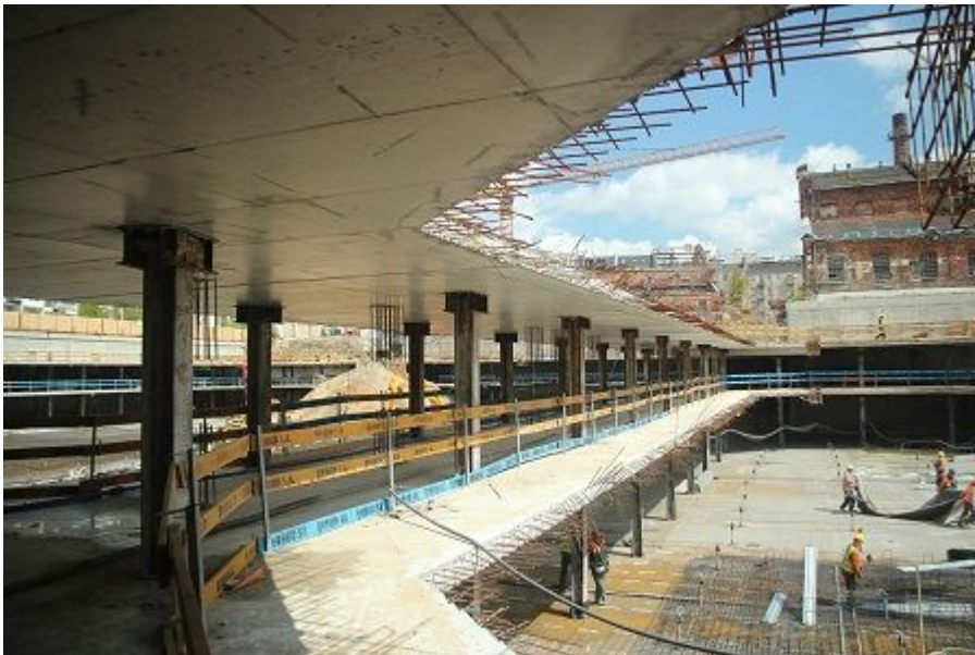
Wykonanie parkingu podziemnego metodą podstropową w Centrum Praskim Koneser, Warszawa. Fot. od Soletanche Polska sp. z o.o. w Warszawie
