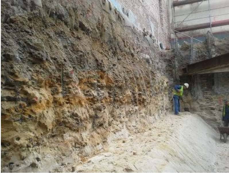
Roboty fundamentowe w Centrum Praskim Koneser, Warszawa. Fot. od Soletanche Polska sp. z o.o. w Warszawie
