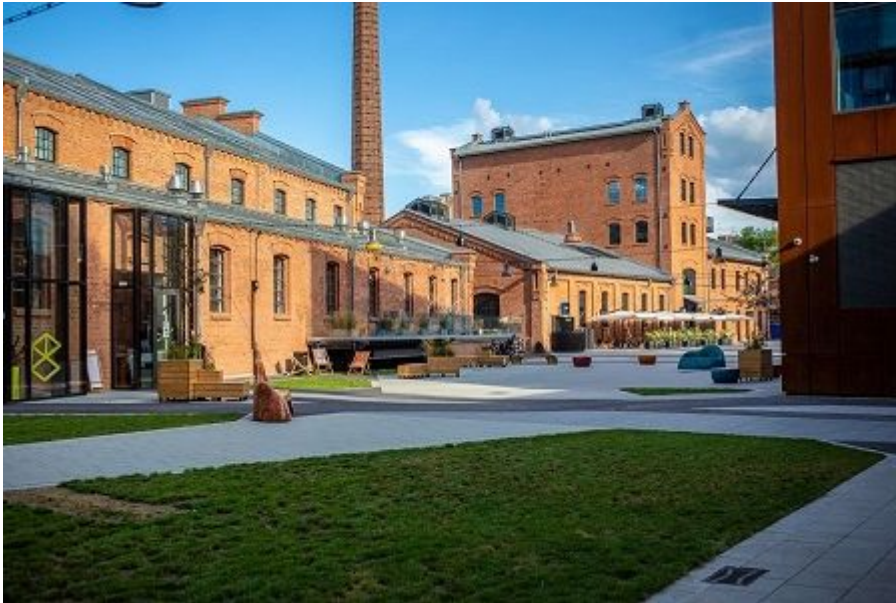
Centrum Praskie Koneser, Warszawa. Fot. od Soletanche Polska sp. z o.o. w Warszawie
