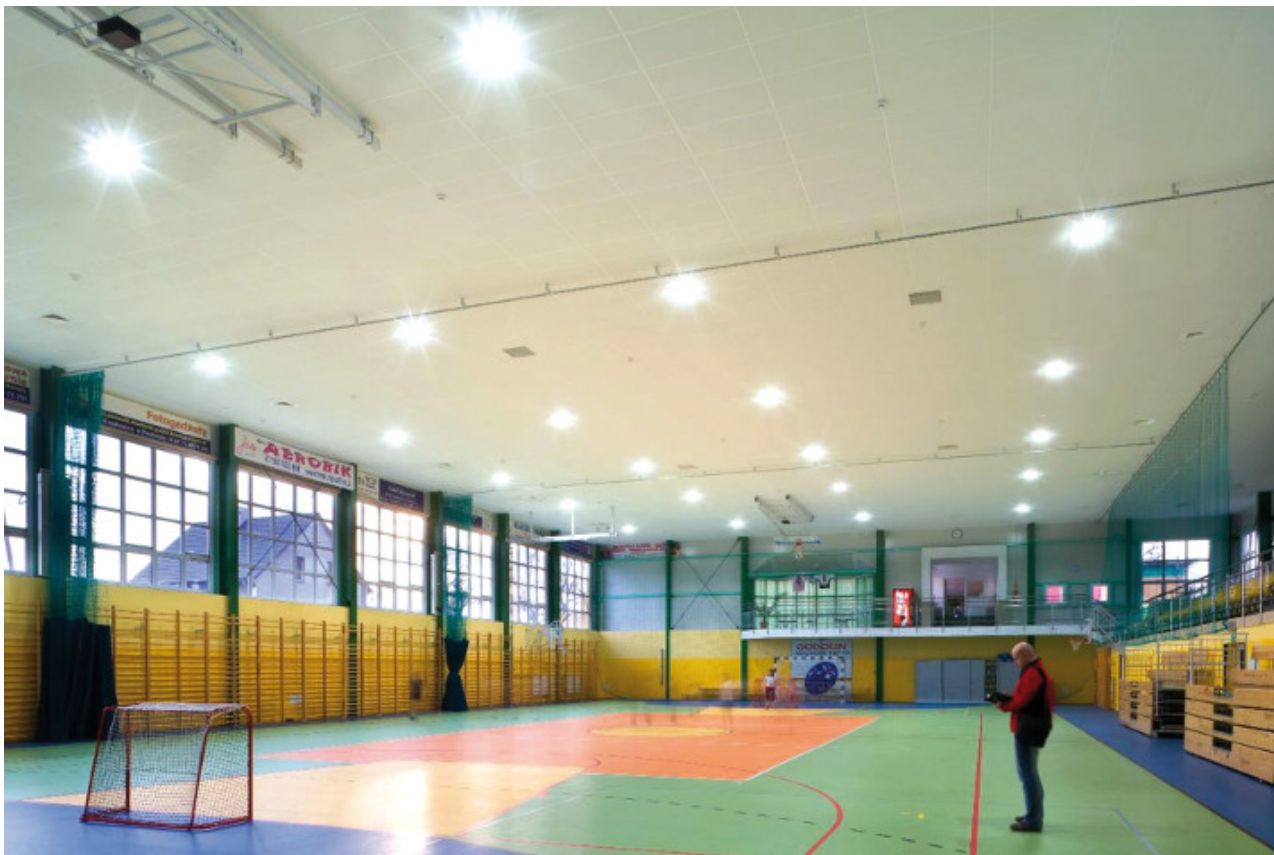
Sala sportowa przy SP nr 3 w Gogolinie. Dźwiękochłonny sufit podwieszany na całej powierzchni sali. Dźwiękochłonne panele ściennie instalowane na ścianie szczytowej na poziomie I piętra (szare pola). Fot.: Szymon Polański
