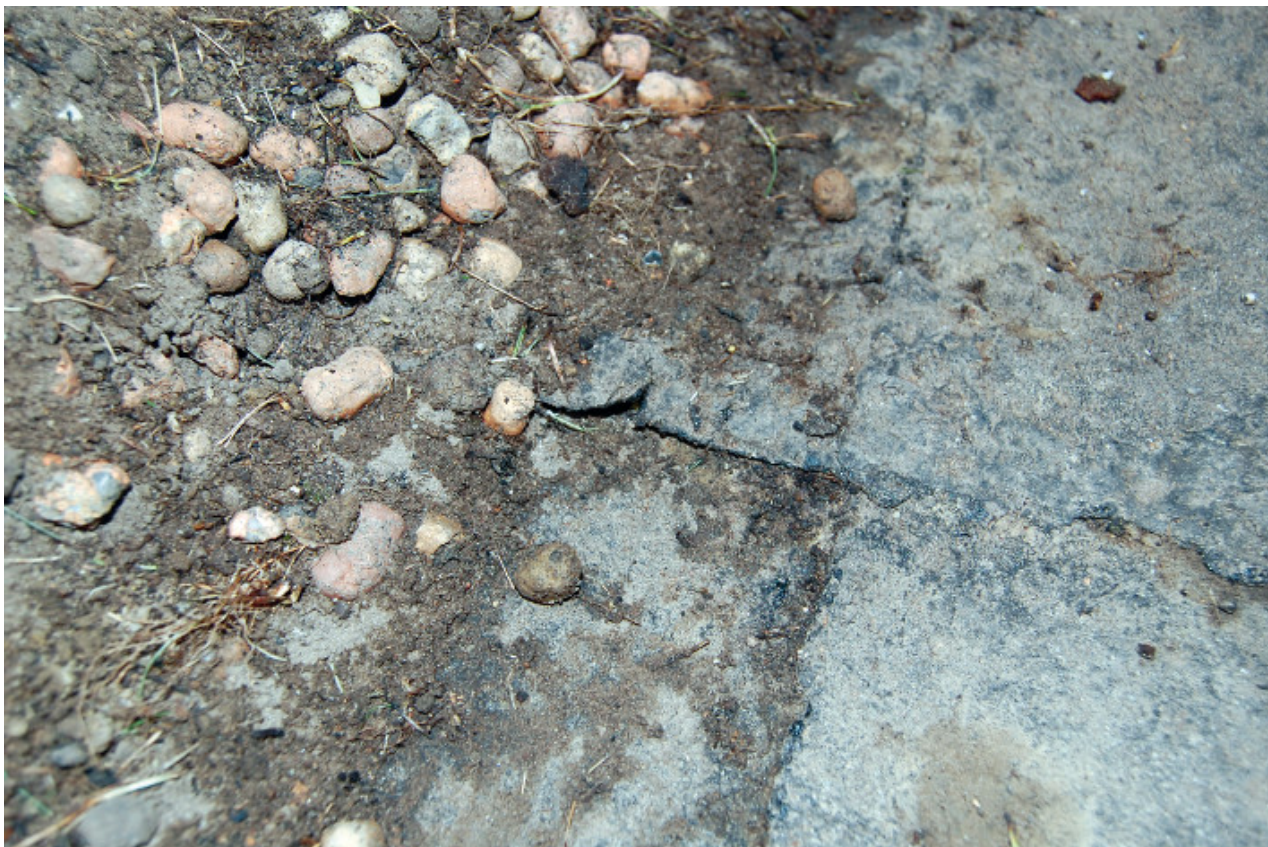
Fot. 1. Papa zdegradowana przez kwasy humusowe
