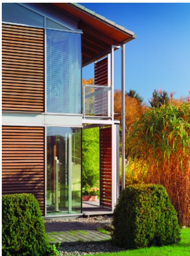
Fot. 1. Budynek z elementami zaciniającymi - zewnętrznymi
