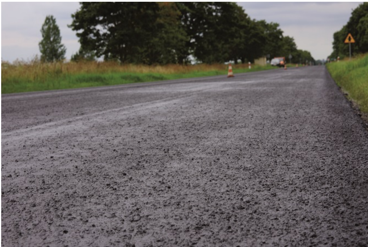
Fot. 1. Warstwa „slurry seal” (fot. Paweł Tofliński)
