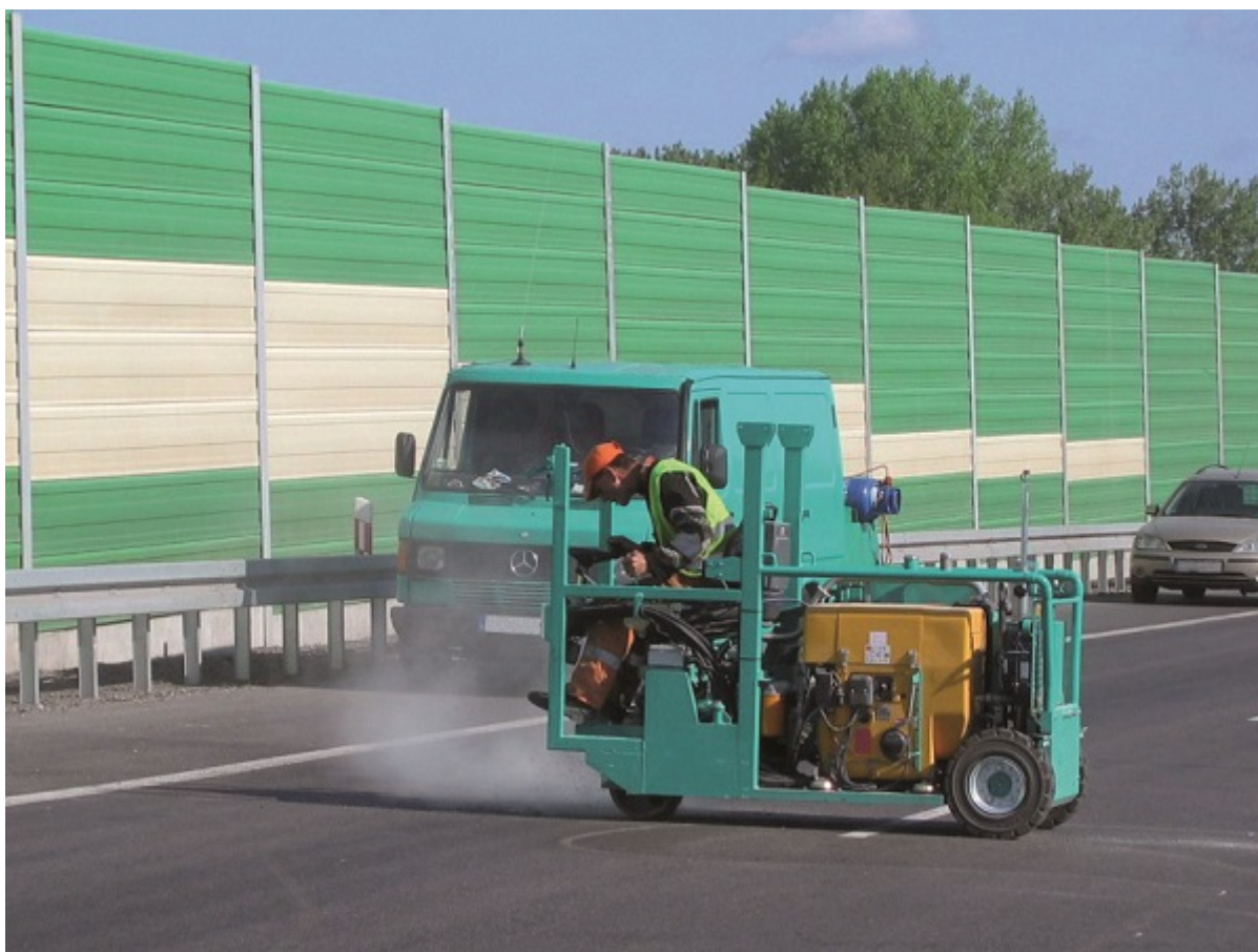
3. Frezowanie szczeliny pęknięcia [6]
