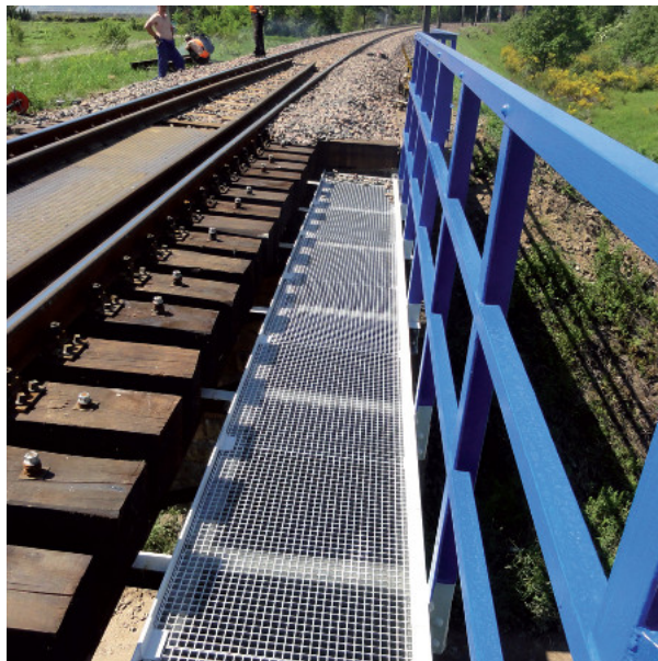
Fot. 1. Przykład obiektu z nawierzchnią kolejową na mostownicach
