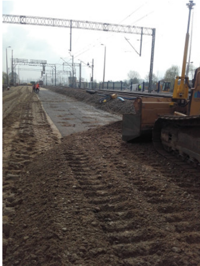
Fot. 4. Układanie geosyntetyków w podtorzu
