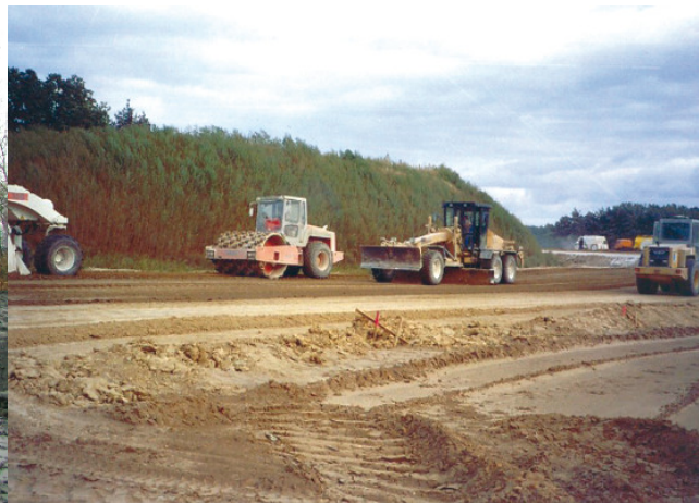
Fot. 6. Drogowe roboty ziemne
