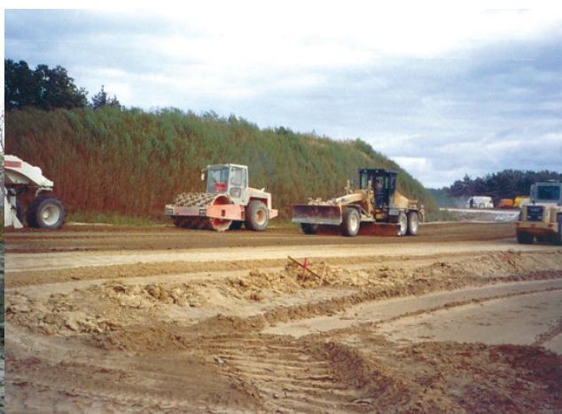
Fot. 6. Drogowe roboty ziemne
