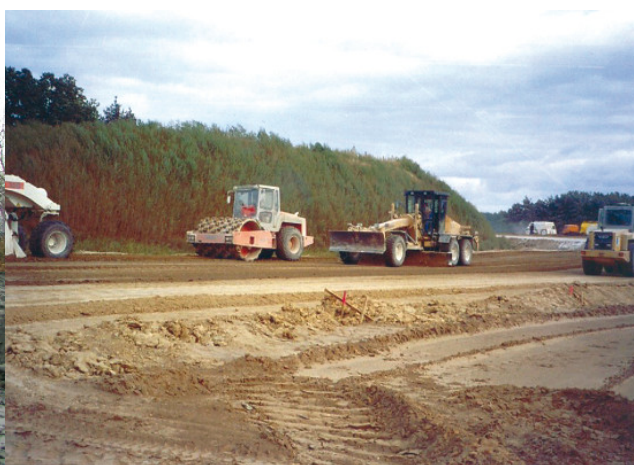
Fot. 6. Drogowe roboty ziemne
