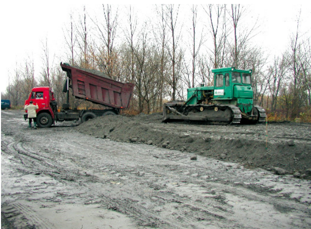
Fot. 5. Drogowe roboty ziemne
