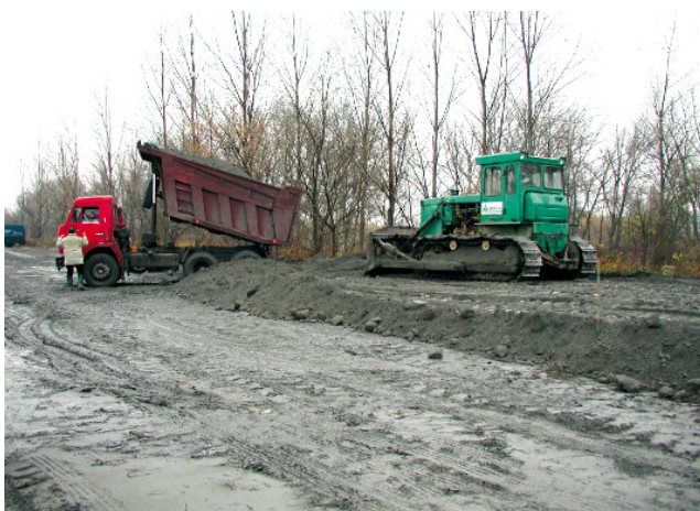
Fot. 5. Drogowe roboty ziemne
