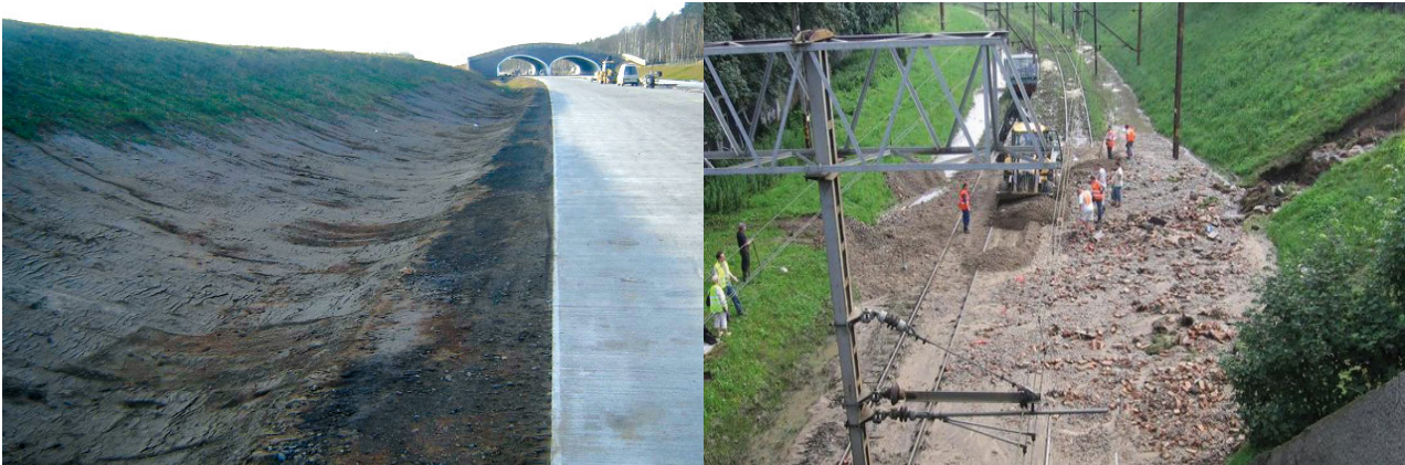
Fot. 2. Uszkodzenie skarpy przez deszcz nawałny na skutek braku rowu stokowego
