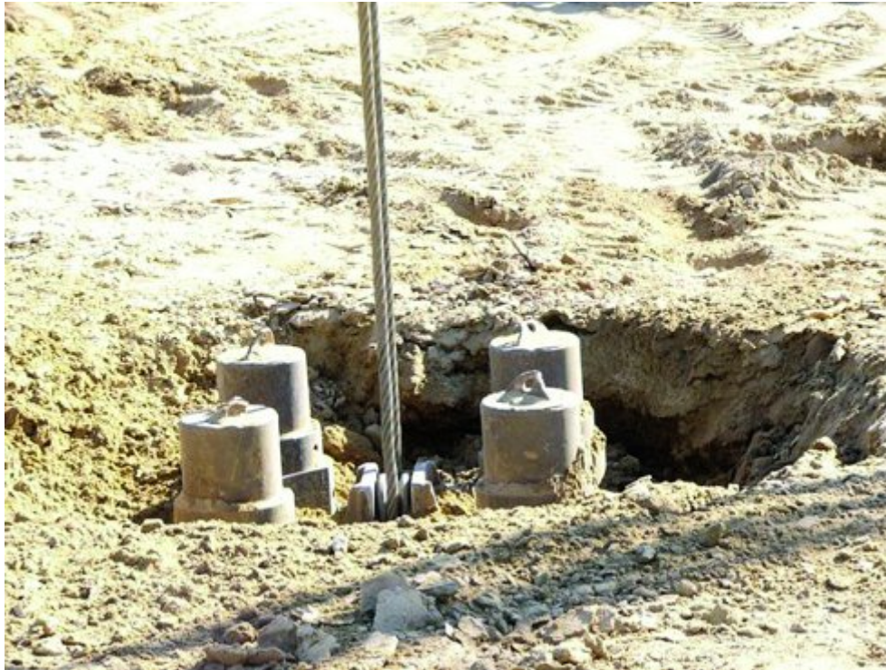
Fot. 3. Zagłębienie bijaka w czasie formowania kolumny
