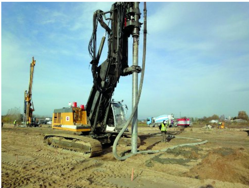
Fot. 11. Widok maszyny w czasie wykonywania kolumn CMC na obwodnicy Gdańska
