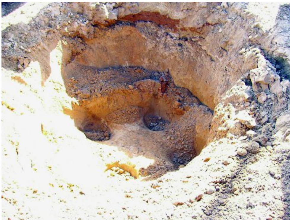
Fot. 4. Widok krateru wybitego przez spadający ciężar
