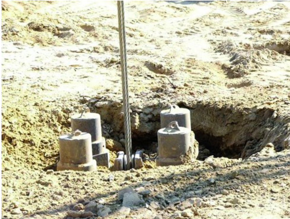
Fot. 3. Zagłębienie bijaka w czasie formowania kolumny
