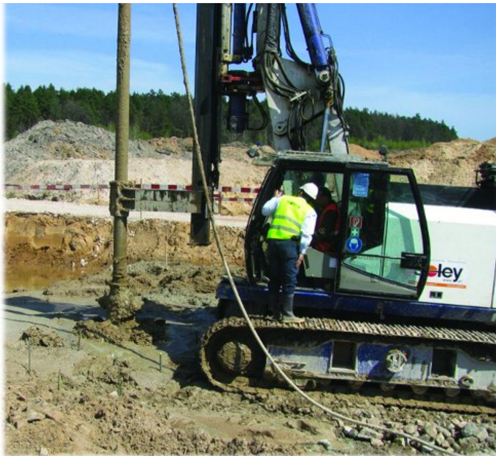
Fot. 9. Maszyna do wykonywania kolumn
