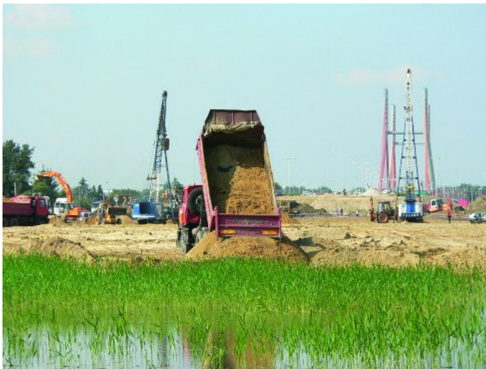
Fot. 1. Wymiana gruntu na dojazdach do Mostu Siekierkowskiego w Warszawie
