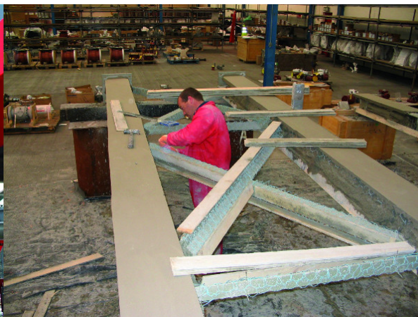
Fot. 5. Zabezpieczenie masą natryskową kratownicy stalowej. Autor: archiwum ITB
