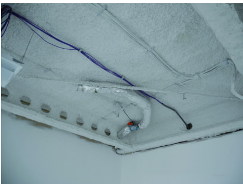
Fot. 6. Zabezpieczenie masą natryskową konstrukcji zespolonej. Autor: archiwum ITB
