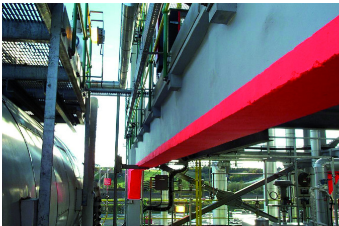
Fot. 4. Zabezpieczenie konstrukcji masą natryskową o odporności ogniowej określonej krzywą węglowodorową. Autor: archiwum ITB
