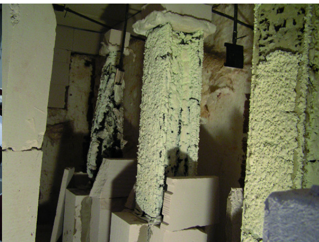
Fot. 12. Widok farby pęczniejącej na elementach stalowych po badaniu odporności ogniowej. Autor: archiwum ITB
