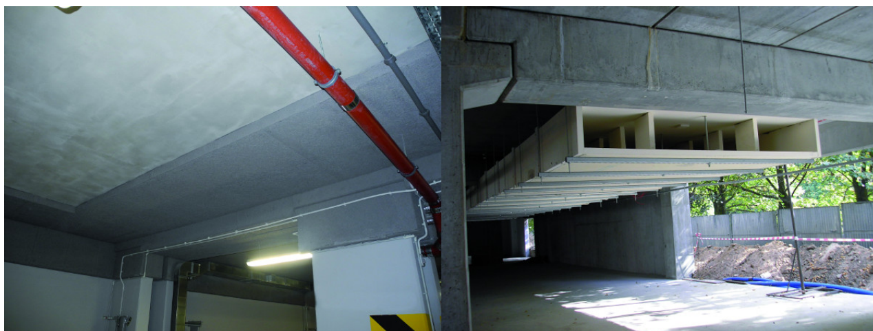
Fot. 8. Kanały do odprowadzania gazów pożarowych wykonane z płyt ogniochronnych – stadion Legii w Warszawie. Autor: archiwum ITB
