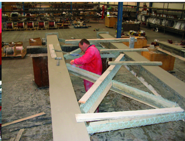
Fot. 5. Zabezpieczenie masą natryskową kratownicy stalowej. Autor: archiwum ITB
