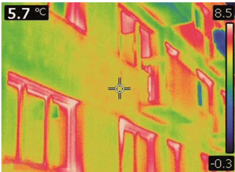
Fot. 2. Fragment elewacji z oknami
