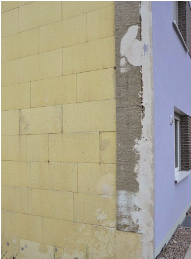
Fot. 1. Renowacja ocieplenia
