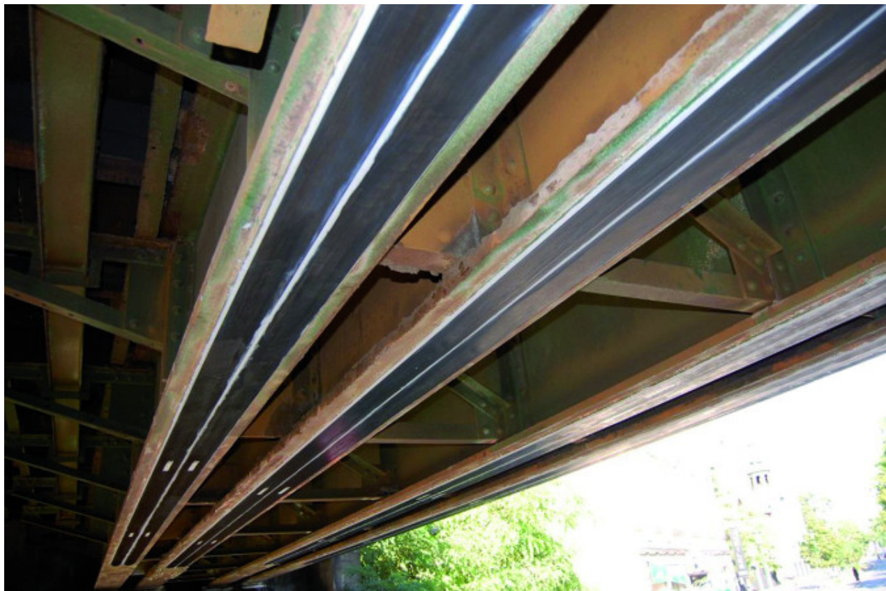
Fot. 3. Typowy stalowy most belkowy wzmocniony taśmami kompozytowymi
