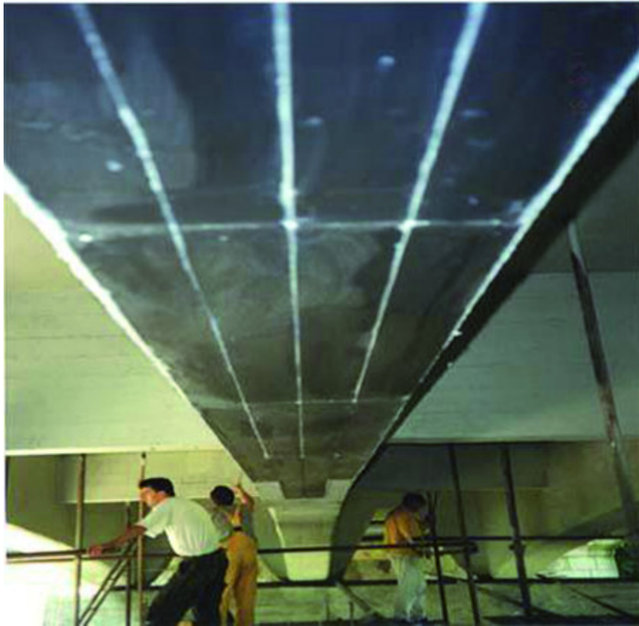
Fot. 1. Wzmocnienie przęsła nurtowego mostu w Przemyślu taśmami CFRP
