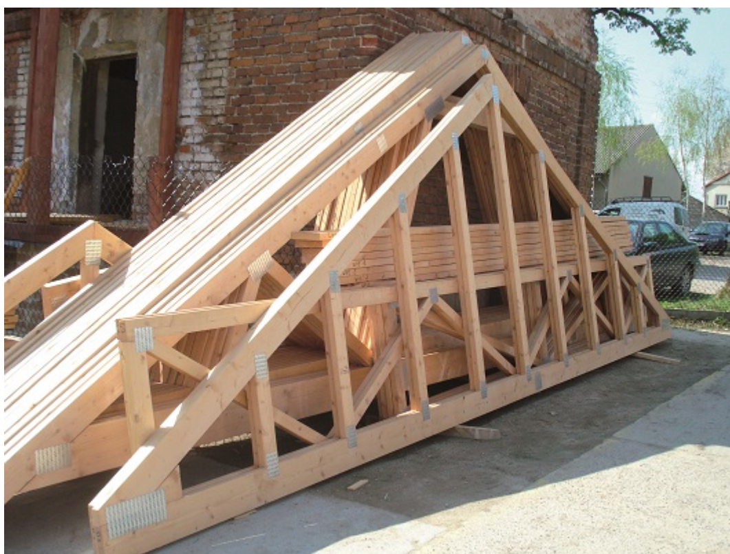
prostych prefabrykacji (dźwigar kratowy na płytki kolczaste) (źródło autora)
