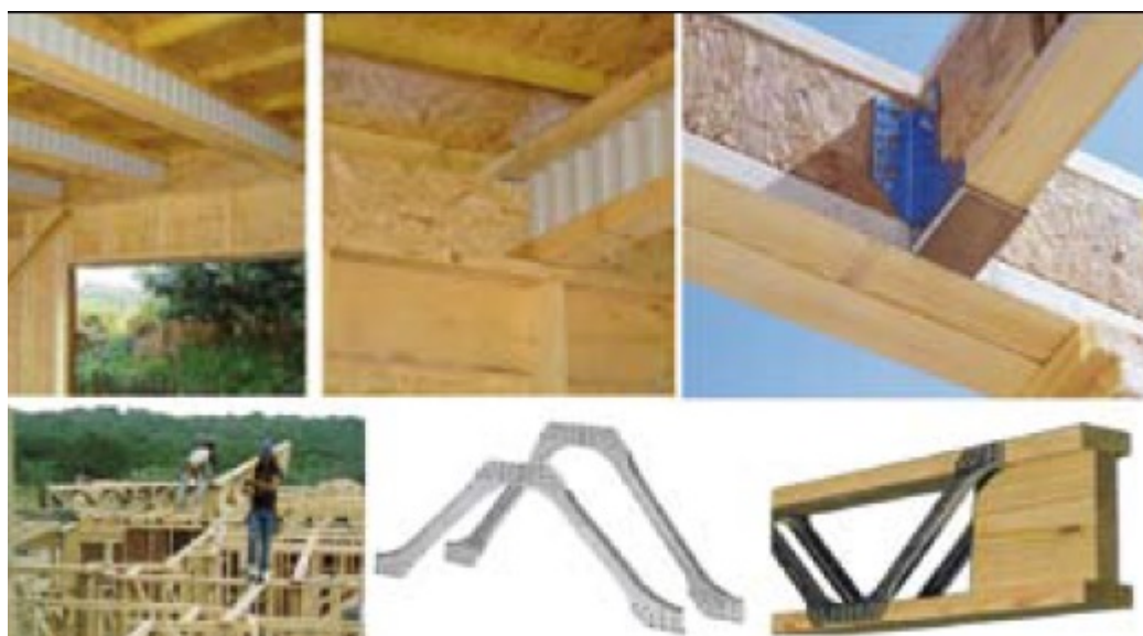
Przykładowe złożone belki stropowe na bazie drewna
