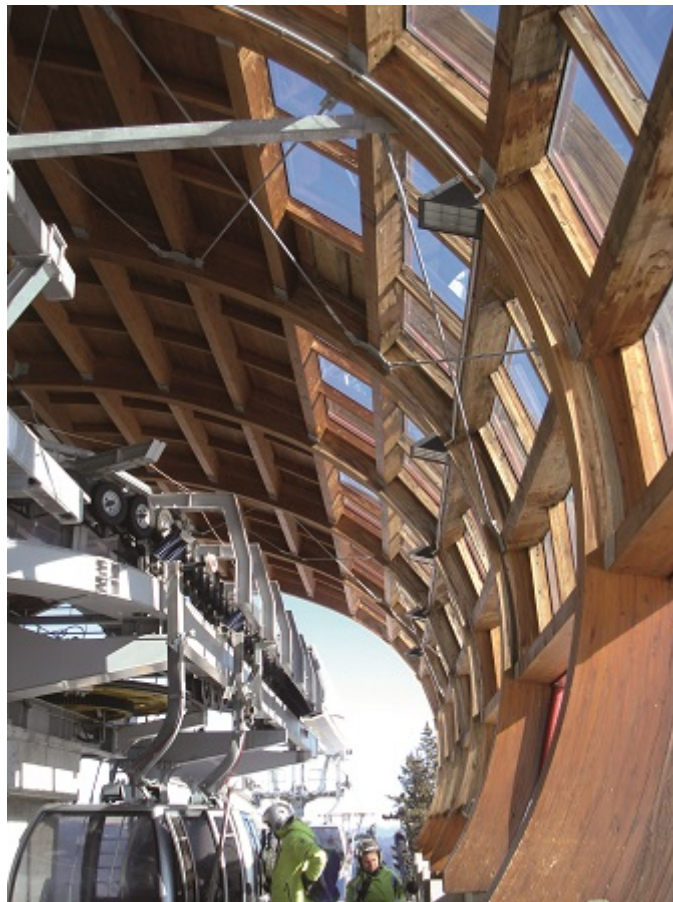
Fot. 11. Przekrycie w łuku nad stacją kolejki górskiej (Pejo - Włochy) (źródło autora)
