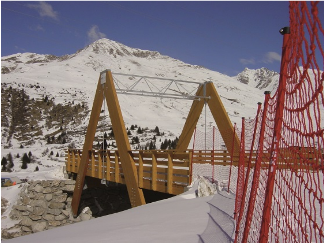
Fot. 14. Drewniana kładka na trasie narciarskiej (Pejo - Włochy) (źródło autora)
