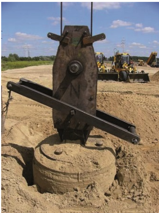
Fot. 4. Formowanie kolumny wybijanej
