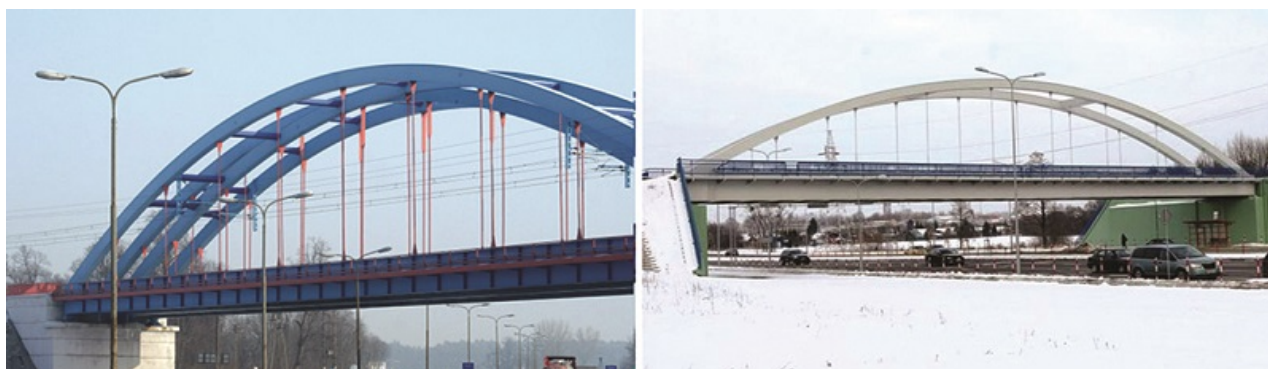
Fot. 8. Przykłady kolejowych mostów i wiaduktów łukowych typu Langerera
