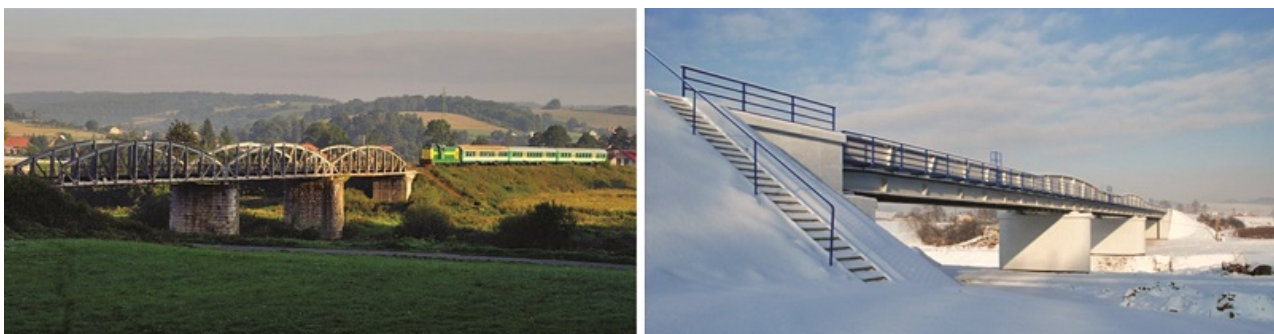
Fot. 6. Most nad Wisłokiem w Czudcu przed i po modernizacji
