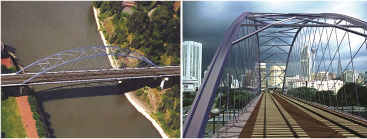
Fot. 9. Łukowy most kolejowych typu „network arch” [2]
