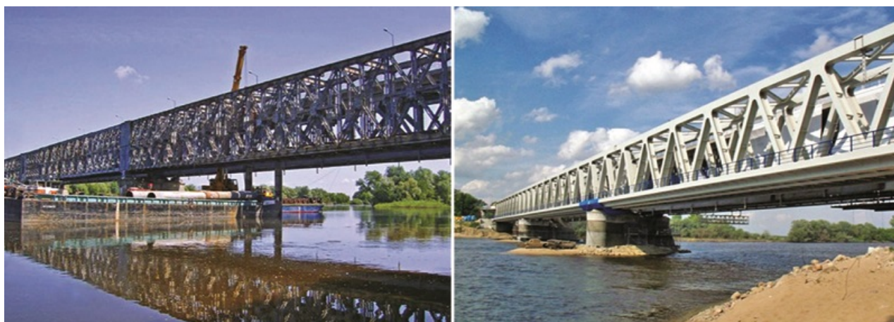
Fot. 7. Stary i nowy most kolejowy przez Narew w Modlinie
