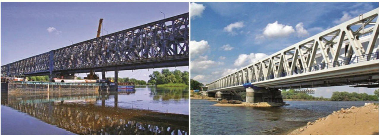
Fot. 7. Stary i nowy most kolejowy przez Narew w Modlinie
