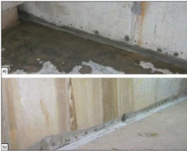
Fot. 6. Uszczelnienie ściany betonowej metodą iniekcji wysokociśnieniowej: a) założone iniektory i uszczelniona powierzchnia rakowata, b) osuszona ściana
