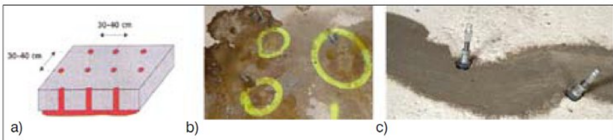
Rys. 8. Przykład uszczelniania płyty fundamentowej kurtynowo i powierzchniowo: a) typowe odległości między otworami iniekcyjnymi, b) przykład iniekcji powierzchniowej, c) iniekcja do rysy w posadzce, rysa powierzchniowo zamknięta, iniektory osadzone pod kątem 45^\circ
