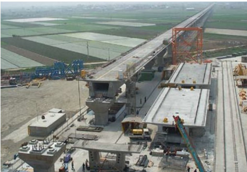
Fot. 2. Taiwan High Speed Railway – przykład wykorzystania betonu SCC wysokiej wytrzymałości
