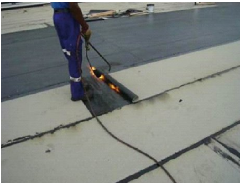
Fot. 1. Klejenie papy termozgrzewalnej do podłoża betonowego z użyciem palnika gazowego
