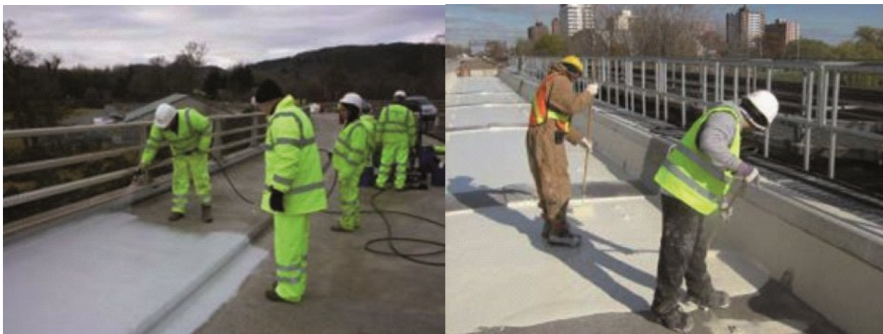
Fot. 2. Wykonywanie hydroizolacji żywicą MMA na obiekcie mostowym metodą natryskową i ręczną [8]
