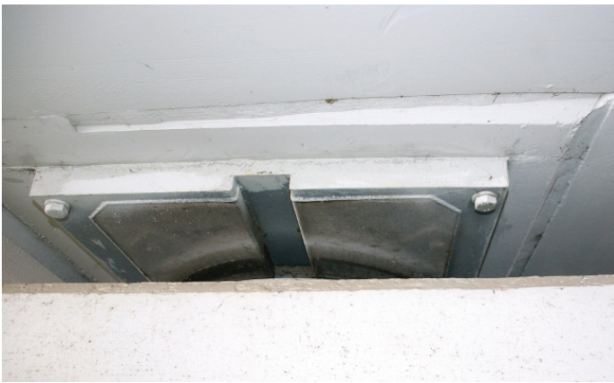
Fot. 2. Widok kanału prowadnicy w łożysku jednokierunkowo przesunym
