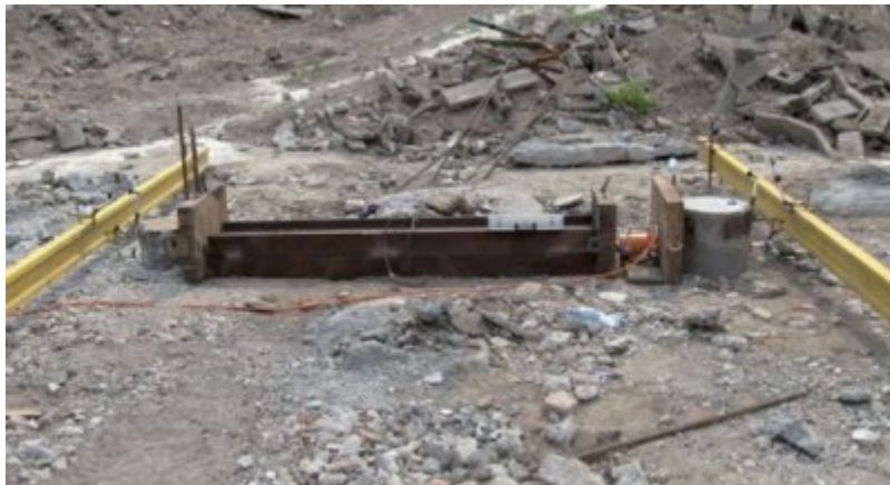
Fot. 6. Przykład badań porównawczych – próbné obciążenia na siły poziome dwóch różnych rodzajów pali
