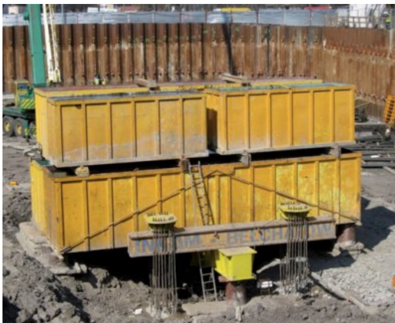
Fot. 2. Konstrukcja z wykorzystaniem zbiorników balastowych
