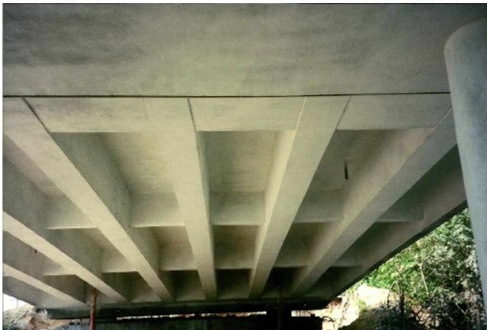
Fot. 3. Przeszło mostu belkowego po naprawie
