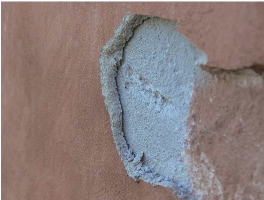
tynk mineralny. Ewidentny brak przyczepności do podłoża
