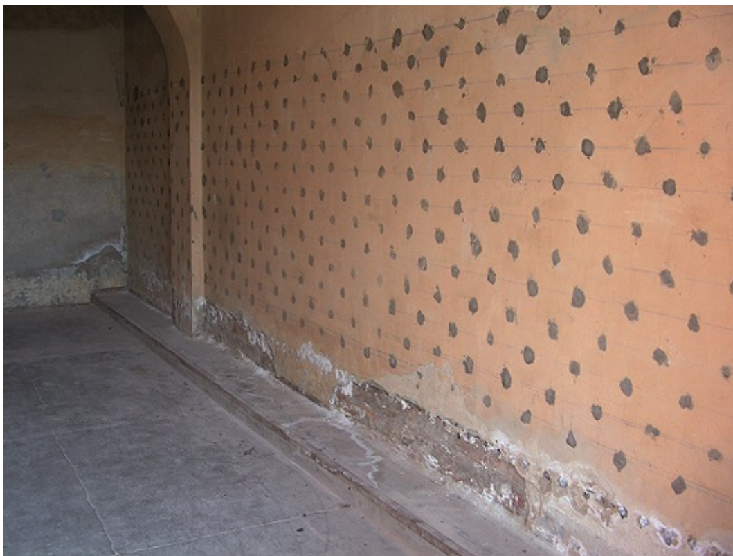
Fot. 4. Ściana po
