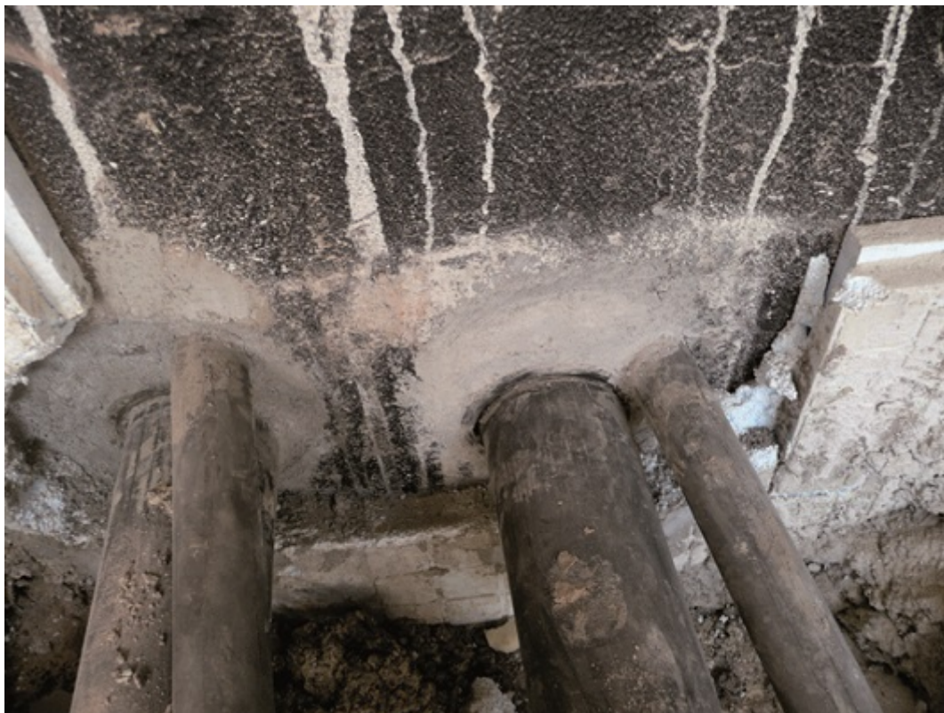
Niewłaściwe uszczelnienie przejścia rurociągu – fot. M. Rokiel
