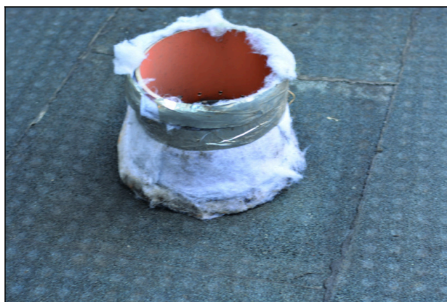
Fot. 4. Skrzynka kontrolna bez pierścienia odciążającego ustawiona bezpośrednio na papierze, bez perforacji, owinięta włókniną (fot. autora)
