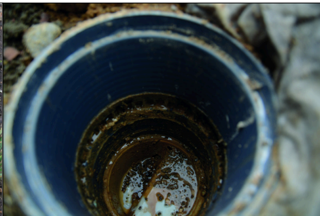
Fot. 2. Zakamieniony pierścień „przedłużki” (fot. autora)
