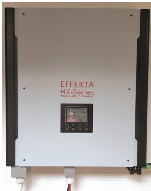
Fot. 10. Solarny falownik hybrydowy (zdjęcie własne autora)
