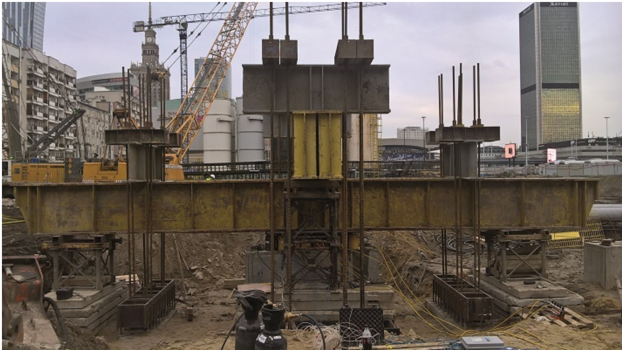
Fot. 1. Widok konstrukcji badanej baretę (fot. autora)
