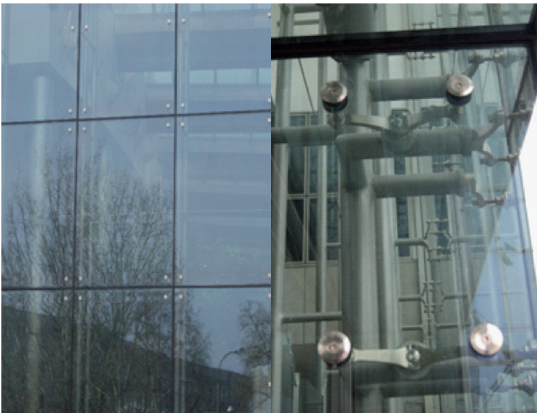
Fot. 1. Widok ściany mocowanej punktowo
